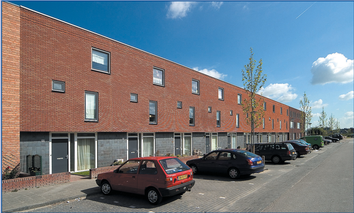
Nieuwbouw 156 huurwoningen Hogevelde te Den Haag
